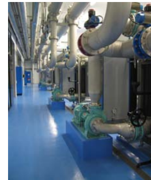
Insgesamt sind 4 Membranfilter-Racks in Betrieb
