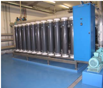
Membranfilter-Rack mit Steuerschrank Rittmeyer
